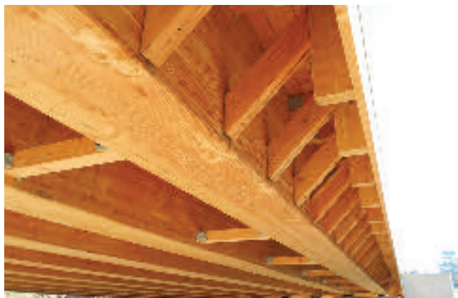
Pont de Cognin (73). Crédit Photo : Chambéry Métropole.
